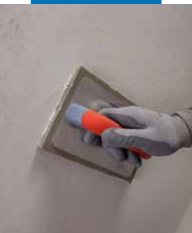
Konečná úprava Mape-Antique FC Civile vlhkým houbovým hladítkem
